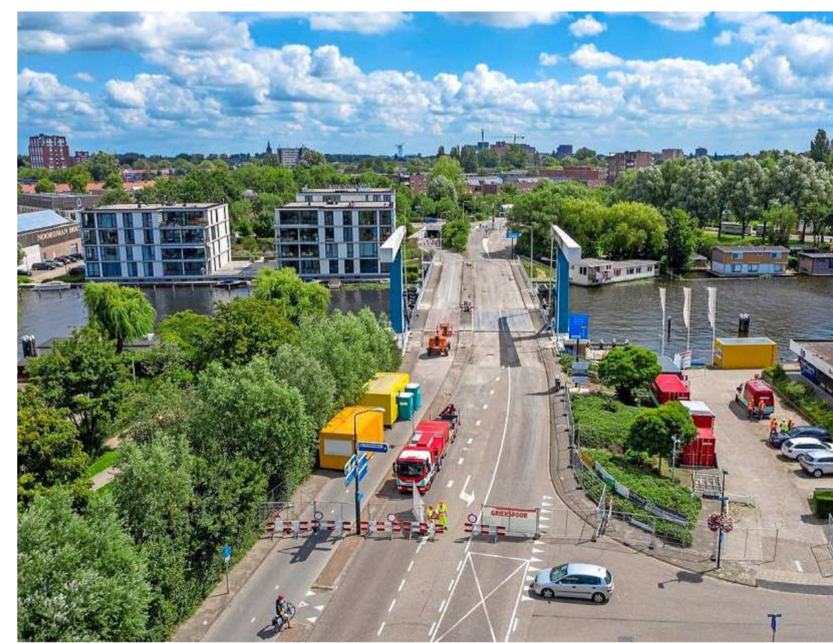
De Churchillbrug is twee maanden dicht voor renovatie.
