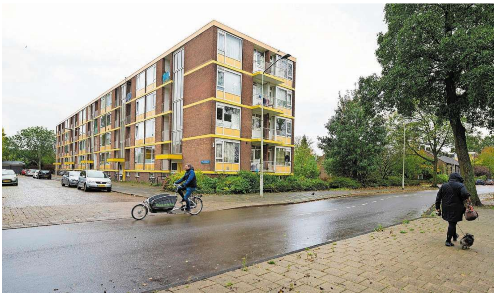
De flat aan de Wiardi Beckmanstraat wordt gesloopt.
